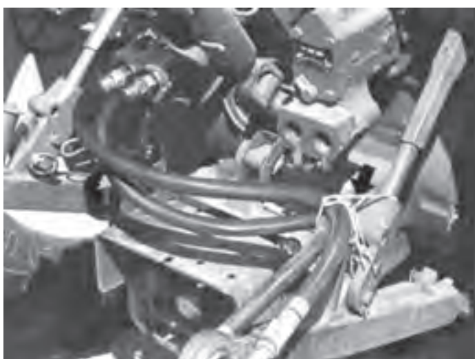
شکل ۱۳-۶- مهار نامناسب شیلنگ‌های هیدرولیک
